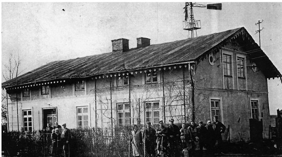
Das hochragende Windrad war lange Jahre gleichsam ein Wahrzeichen dieses Hofes. Es trieb eine Pumpe an, welche das Anwesen mit Wasser versorgte. 1943 wurde das Windrad abgebaut. – Ein Neubau des Wohnhauses war geplant, kam jedoch kriegsbedingt nicht zur Ausführung. Vor dem Gebäude posieren die Besitzerfamilie und die Betriebsangehörigen.
