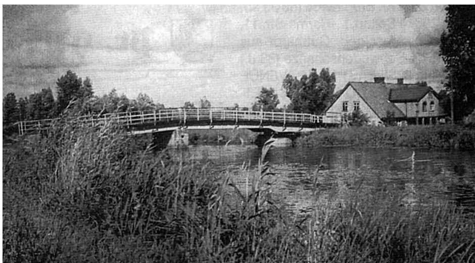
Die Sorge mit der in Neu-Dollstädt gelegenen Gaststätte Daniel. Das Mittelteil der Brücke ist mittels Drehkreuz und Rollen schwenkbar, um den Schiffsverkehr auf der Sorge nicht zu behindern.
