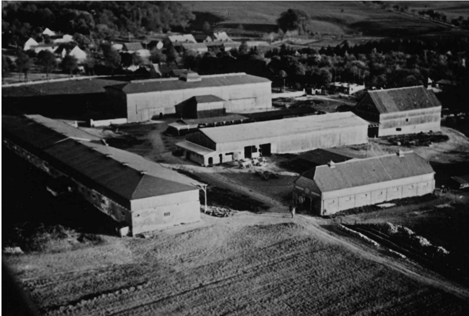
Der Gutshof: links Rindviehstall. Auf diesen weisen mit den Giebeln große Scheune, kleine Scheune mit Kälberstallanbau, in Verlängerung dieser Scheune der Speicher und im Vordergrund der Arbeitspferdestall.
